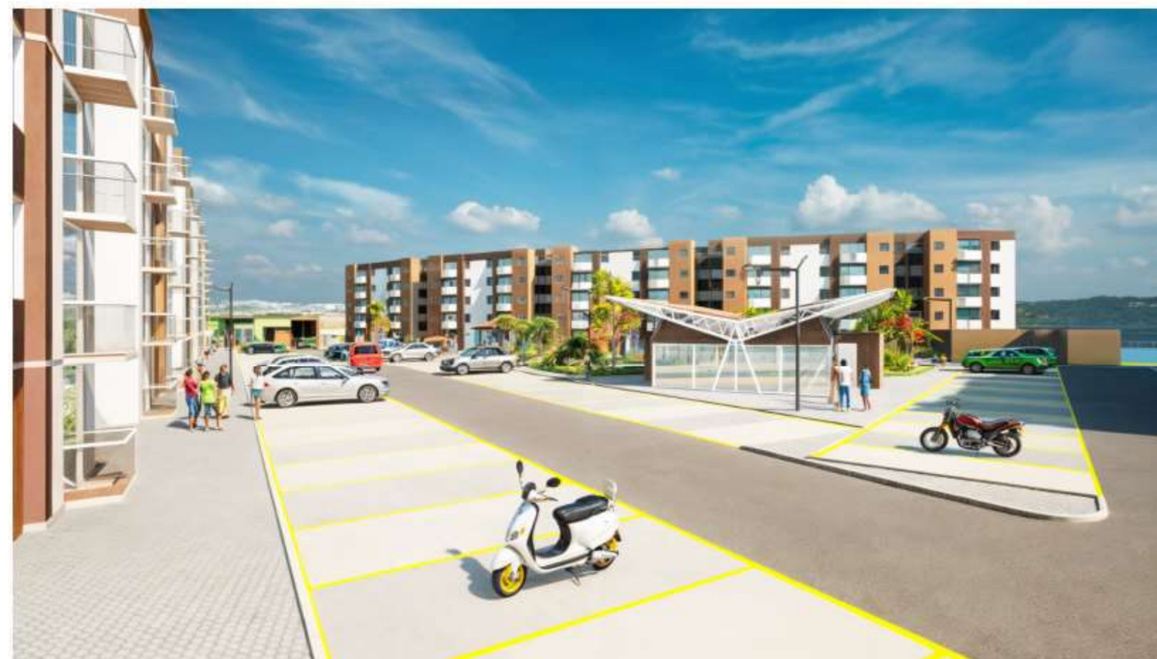
Salón comunal y zonas exteriores del conjunto
